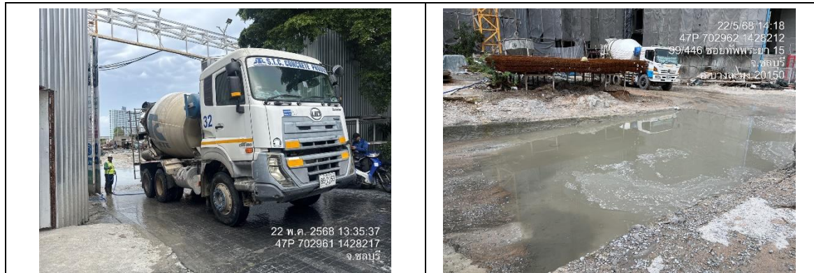
รูปที่ 5 พื้นที่ล้างล้อรถก่อนออกจากพื้นที่โครงการ
